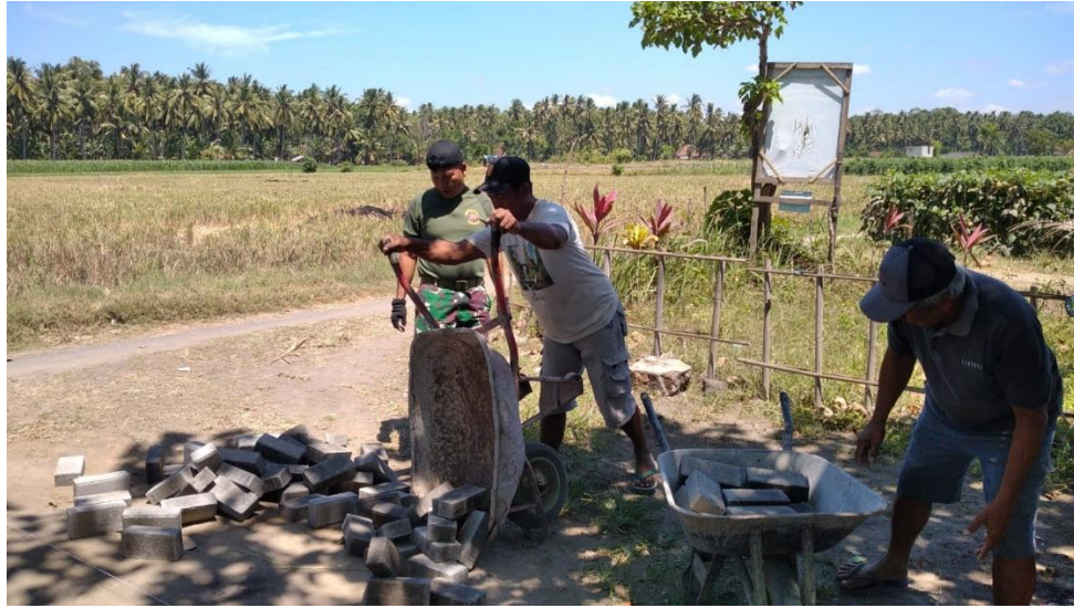
Gambar 2. Tahap Pelaksanaan Pavingisasi Sevara Gotong Royong
